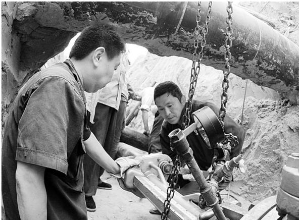
昨日,南四环施工现场,工作人员正在进行不停气碰管施工。
