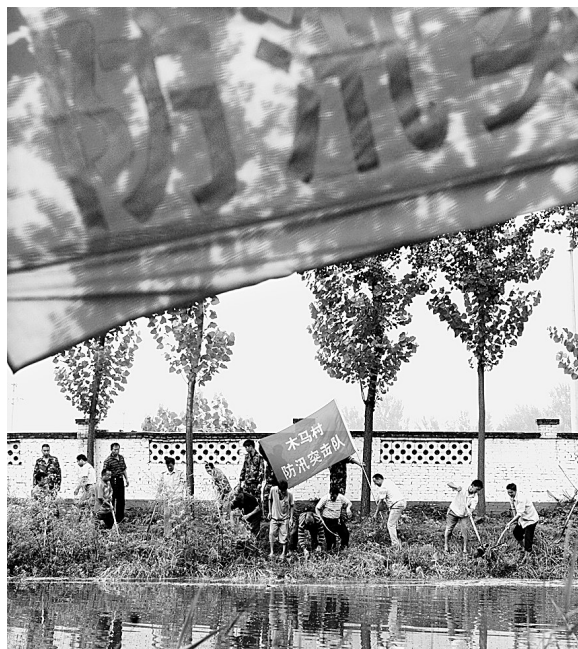
连续的雨水使贾鲁河支流水位持续上升。昨日,迎宾路办事处组成7支防汛突击队,对辖区三条主要沟河进行疏挖,确保辖区居民安全。本报记者 李利强 摄
