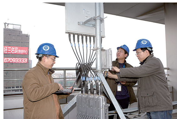
郑州移动技术人员正在加强基站建设
