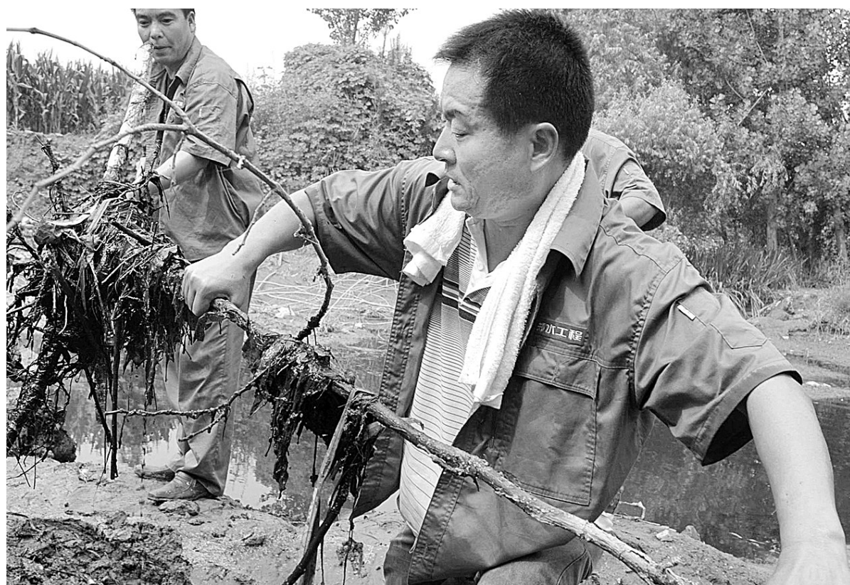
连日高温,市自来水总公司采取多项措施保证夏季高峰供水。昨日,公司职工冒着高温,对尖岗水库至西流湖段渠道进行清淤,保障备用水源输水畅通。本报记者 汪静文 摄
