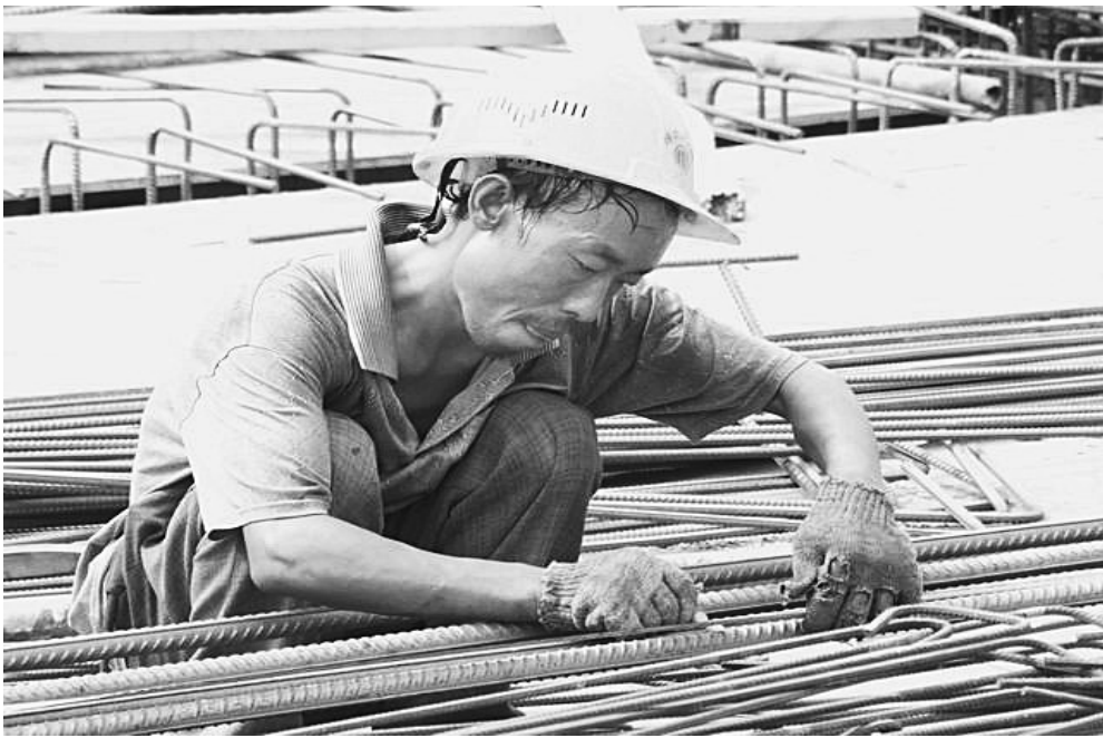
烈日下民工们仍然在进行高空作业
