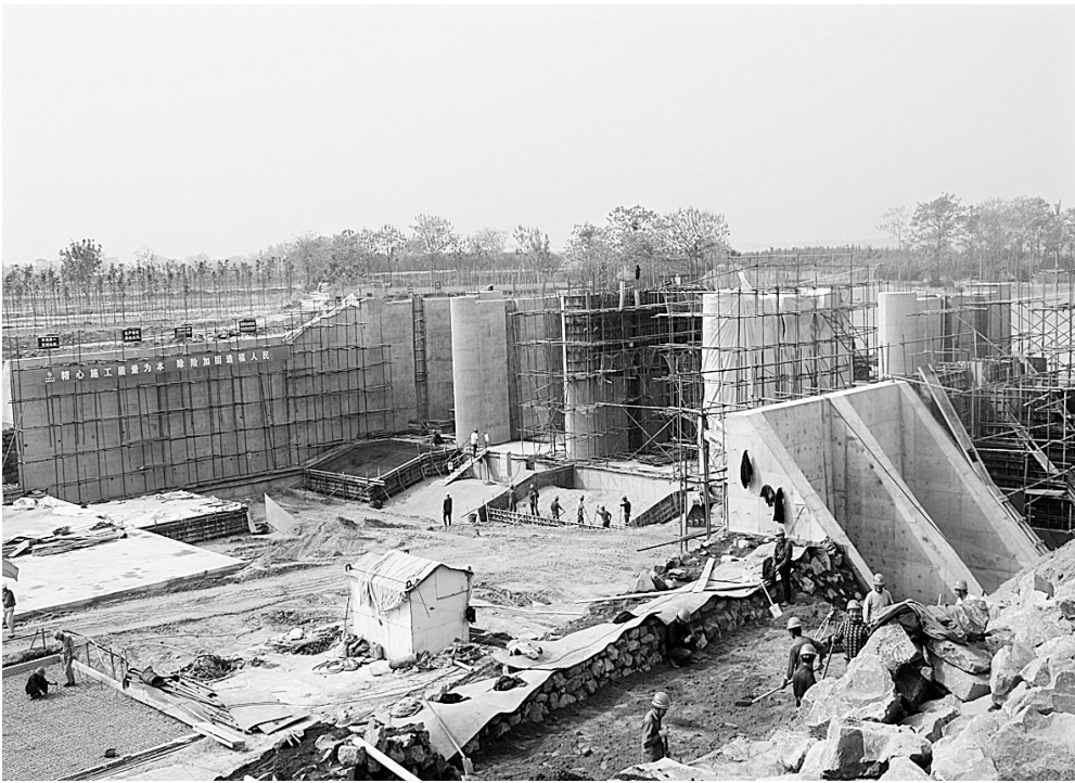
施工中的常庄水库
