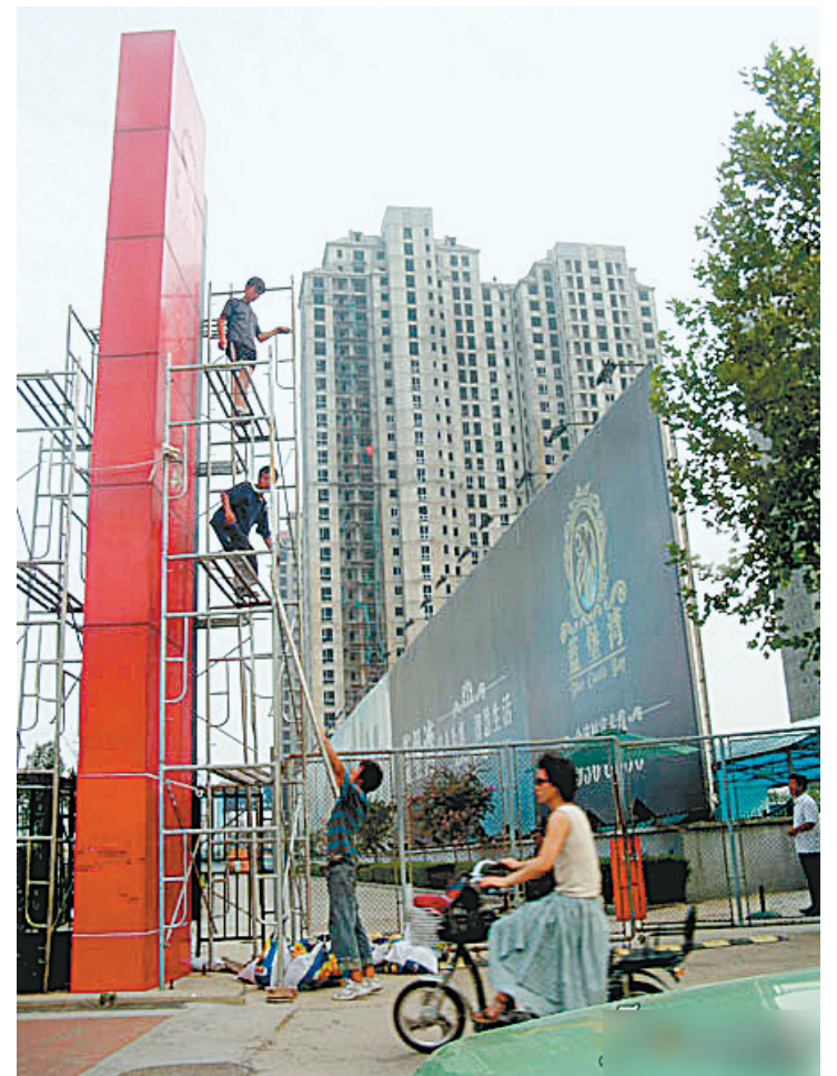
工人正在修改标志
