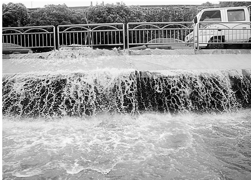
昨日,记者在航海路地下道看到,从慢车道的窨井中往上冒出大量雨水,由于慢车道高于快车道近两米,大量的雨水从慢车道流向快车道,形成了“小瀑布”,给机动车出行带来极大不便。本报记者 宋晖 实习生 徐宗福 摄
