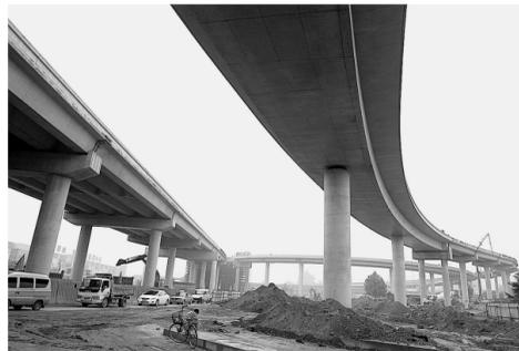
昨日,记者从嵩山路—黄郭路—南三环立交施工现场了解到,立交桥主线和5条匝道相接贯通主体工程基本完工,桥面铺装和防撞墙、护栏等附属结构工程正紧张施工。预计8月底可提前实现通车。本报记者 许大桥 摄
