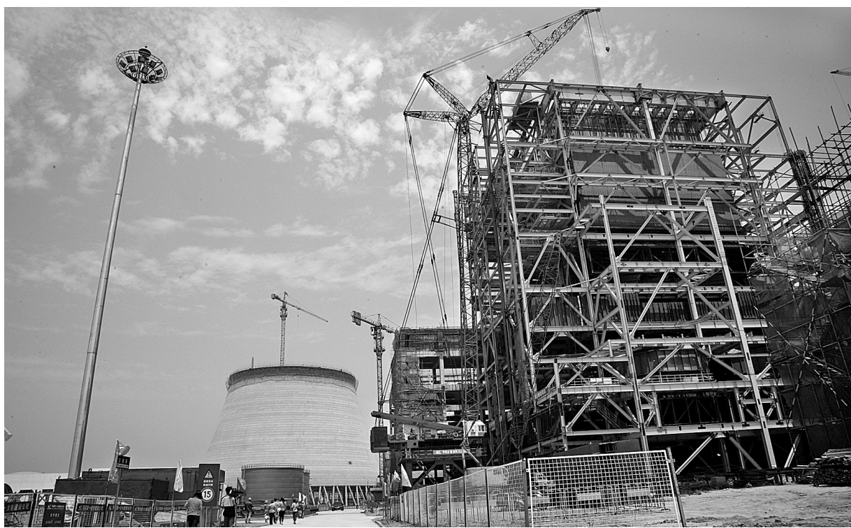
荥阳国电煤电一体化项目工程总投资46.8亿元,是河南省“十一五”规划建设的重点项目,也是中国国电集团公司“十一五”发展规划中的一类重点项目。该项目计划于2010年实现双机投产发电,一期工程竣工投入运营后,年发电能力可达72亿千瓦时以上,售电年收入31亿元以上,每年向国家和地方上缴各种税金可达3亿元,具有良好的环境效益、社会效益和经济效益。记者在现场看到,来自全国的施工队伍,正在加班加点、紧张施工。 本报记者 谢庆 摄
