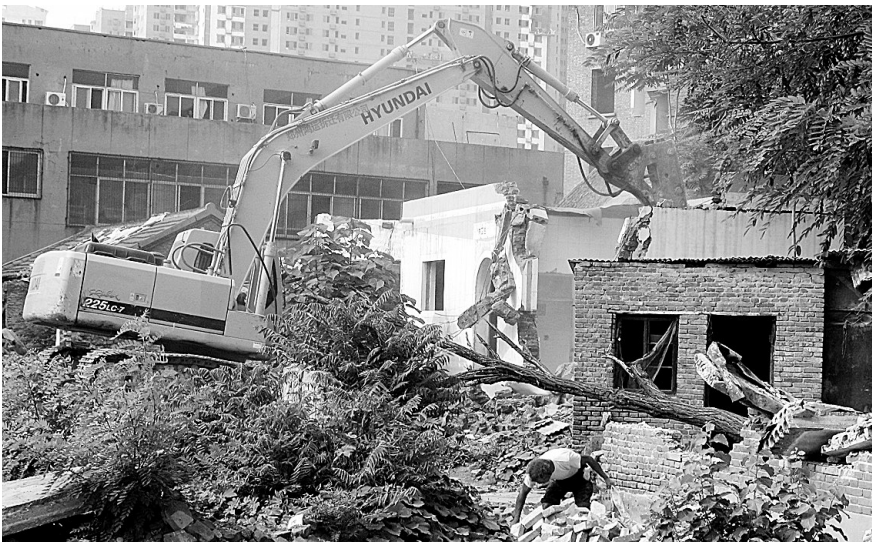
昨日,太和路160号楼车棚被二七区执法局、拆迁办、蜜蜂张办事处等单位联合执法拆除,至此,火车站西广场二期拆迁区域内的15处违章建筑全部拆除到位...
