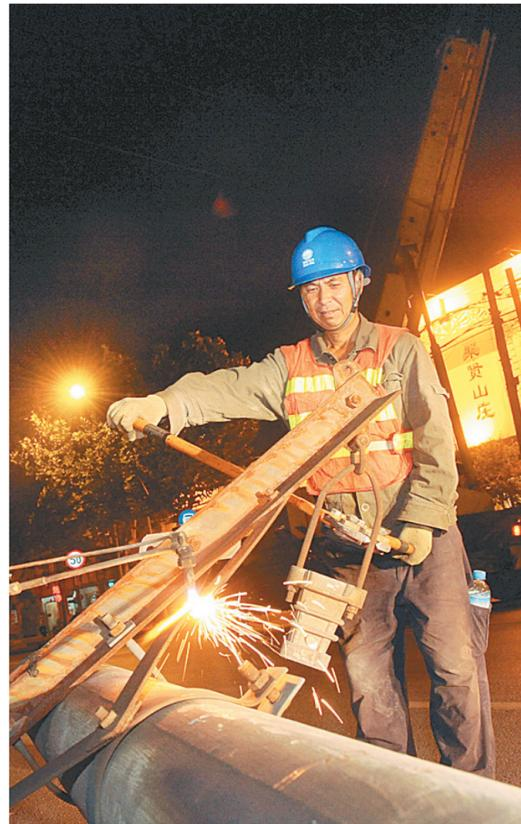
8月31日深夜,电力工人拔除货站街路两边的电线杆。目前,货站街上的56根电线杆已全部拔掉,货站街从此结束了空架电网线路的历史,全部改为地埋线路。 本报记者 李利强摄
