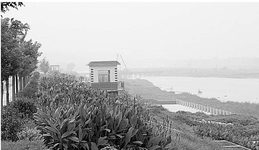
巩义市投资3.2亿元、建设近两年的伊洛河综合治理工程目前基本完工并开始发挥效益。据工程负责人介绍,该工程全长6.4公里,分防洪工程和生态工程两部分。工程的建成使用,有效增加了城区地下水的回灌补源量,缓解了市区水资源严重不足的现状,极大改善了河两岸的灌溉条件和生态环境,成为当地群众观光休闲的好去处。 本报记者 许大桥 摄
