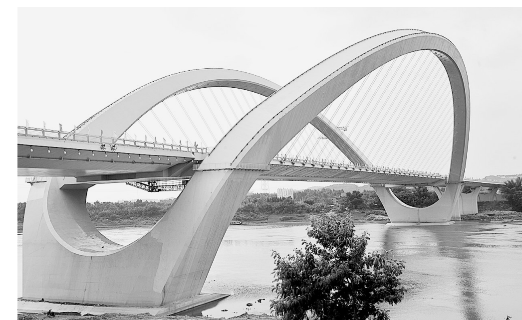
9月21日,大跨径曲线梁非对称外倾拱桥——南宁大桥正式建成通车。南宁大桥横跨邕江两岸,主桥300.50米,引桥长434.00米,引道长580.27米,桥宽、路基宽度35米。桥型由已故美籍华人、著名桥梁设计大师林同炎创意设计,形状如同蝴蝶展翅。南宁大桥创造了中国桥梁史上的诸多第一,成为南宁的标志性建筑。 新华社发
