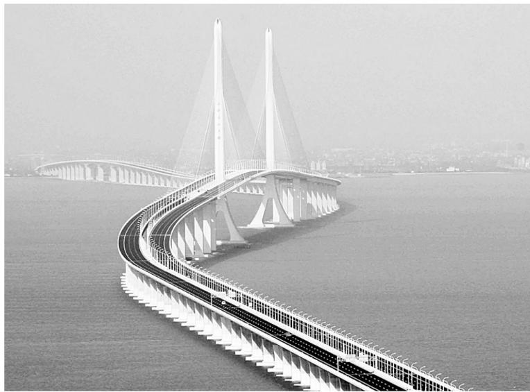
10月23日从空中拍摄的横跨长兴岛和崇明岛的上海长江大桥。该桥是世界上最大的公轨合建斜拉桥,其桥面预留了轨道空间,将来有条件开通城市轨道交通。
