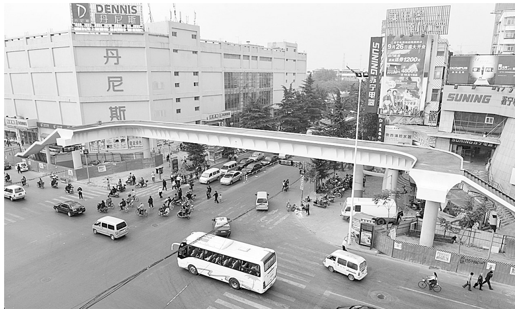
昨日,嵩山路与棉纺路交叉口处过街天桥横跨路面桥体和两个匝道正在施工,天桥雏形已现。作为我市今年修建的8座过街天桥之一,这座天桥投入使用后,将有效改善嵩山路人车混行的现状,使商业场所人流疏散更为方便。 本报记者 丁友明 摄
