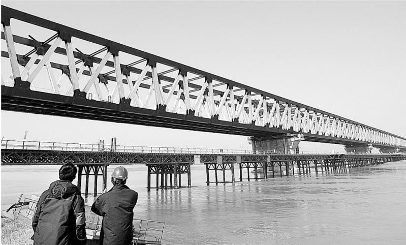
目前,郑州黄河公铁两用桥施工已进入最后的“冲刺阶段”,主桥主跨钢梁已顶推到位,年底前将完成全部公路箱梁架设及主体结构施工任务,2010年7月桥体竣工,10月底正式通车。连接郑州、新乡两地的郑州黄河公铁两用桥,是目前黄河上最长(公铁合建部分9177米)、铁路设计时速最高(350公里/小时)的特大型公铁两用桥。 新华社发
