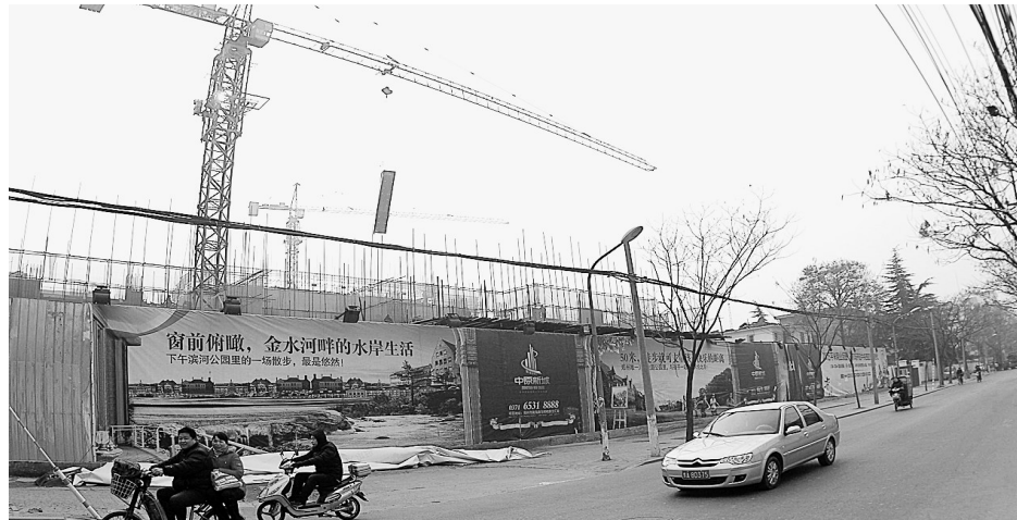
塔吊空中过,行人皆小心。
