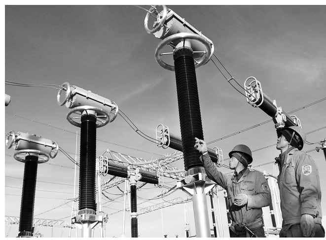
12月8日,在新建成的甘肃酒泉市瓜州北大桥东风电塔330千伏升压站施工现场,技术人员对设备进行检查调试。该工程是我国规划建设的第一座千万千瓦级风电示范基地。新华社发
