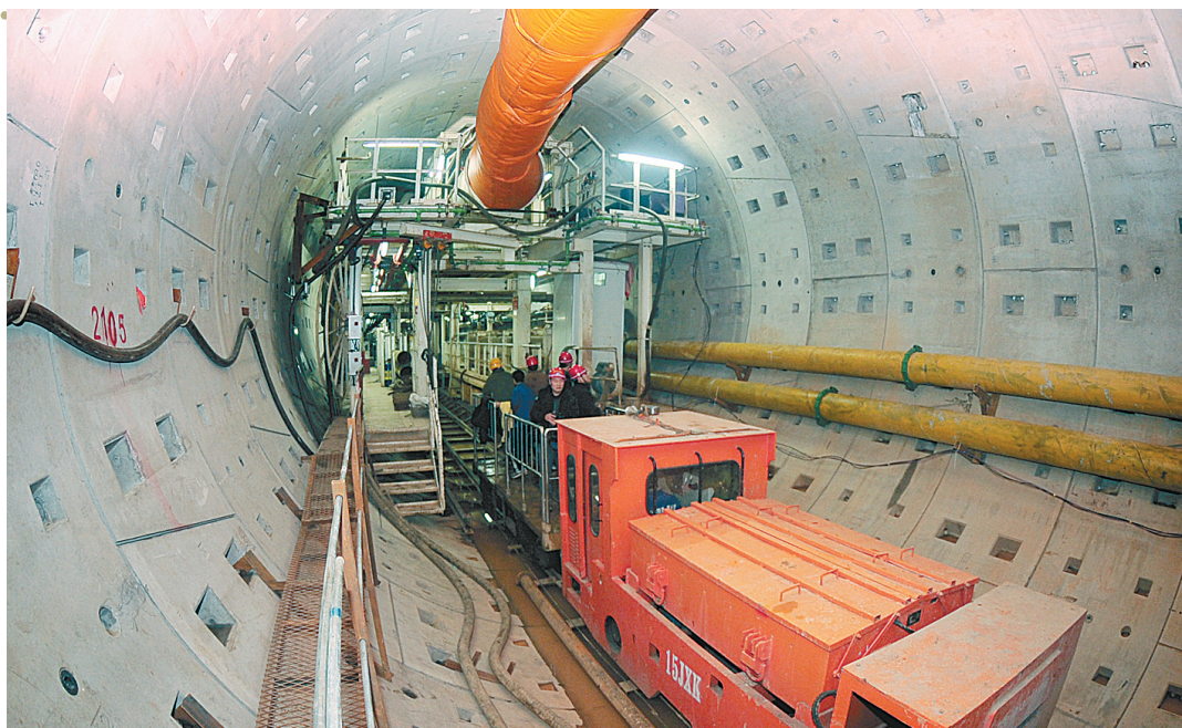
掘进机在黄河河底进行掘进作业(12月15日摄)。
