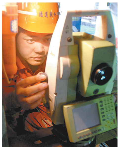
高科技设备的大量使用,使工程质量得到保证。
