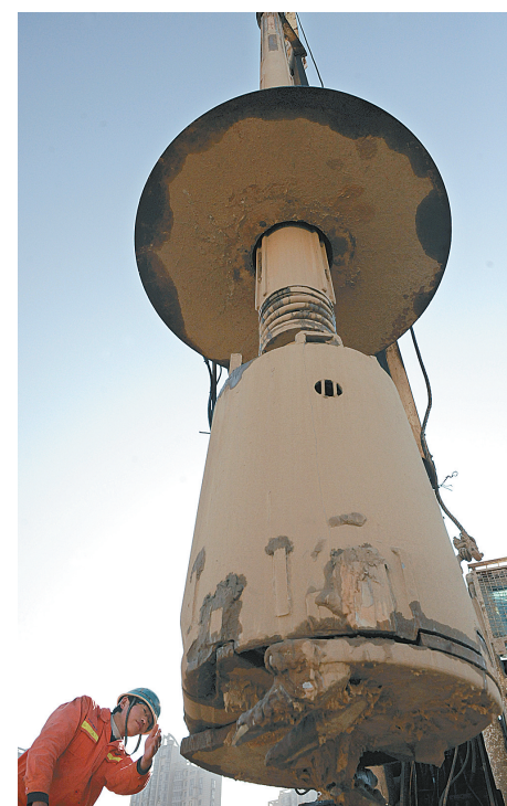
技术人员在钻头下查看地下地质情况。
