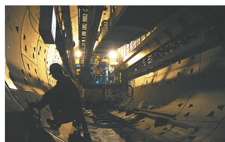
具有世界先进技术水平的盾构机每天不停向前掘进。
