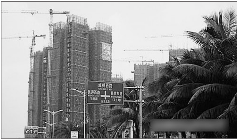
图为正在建设中的海口“八里银海”小区 (资料图片)
