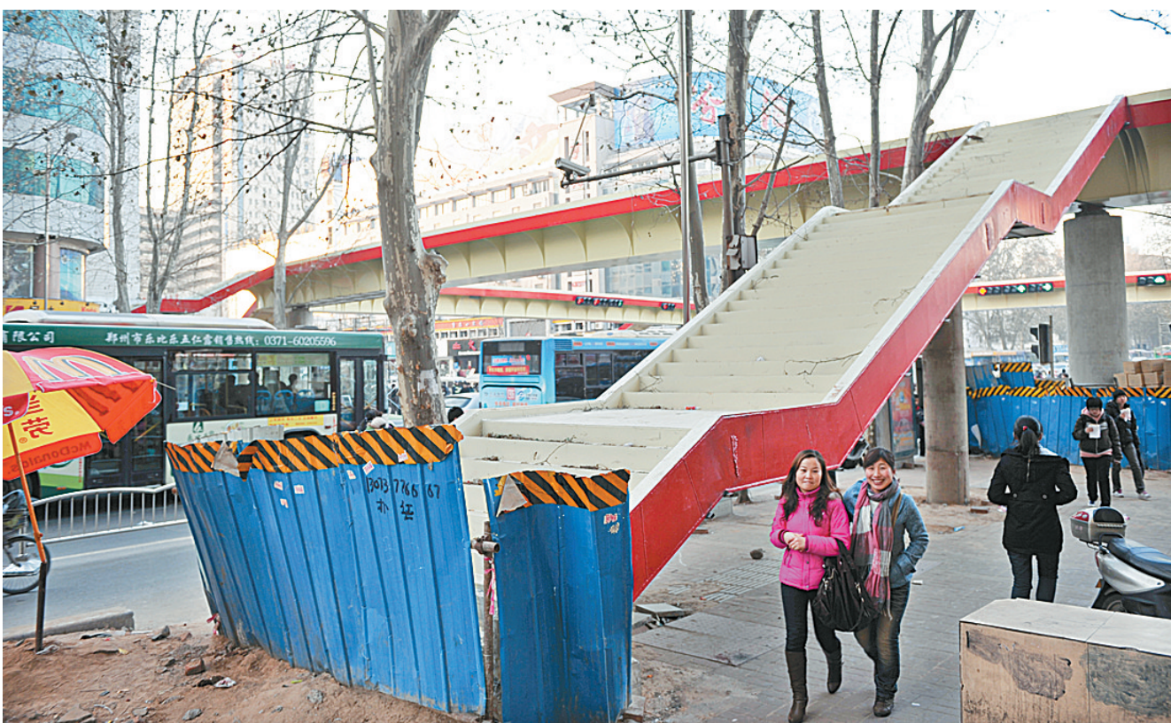
文化路黄河路过街天桥主体工程建成,然而桥面未设护栏,8个阶梯入口未同地面连接,市民不得不在地面上与机动车混行。本报记者 丁友明 摄
