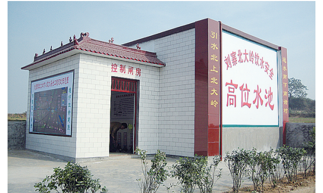
▲2006年以来,市委、市政府连续4年把农村饮水安全工程作为为民办实事之一,投入各级建设资金5亿多元,解决农村饮水不安全人口120万人。从2010年开始,我市将全面启动农村饮水安全村村通自来水工程,力争用4年时间使我市农村自来水普及率达到90%以上。图为建在山区里的农村饮水安全工程。
