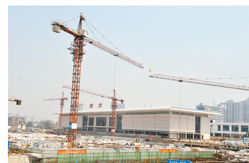
2009年4月 火车站西出站口站房主楼建成。
