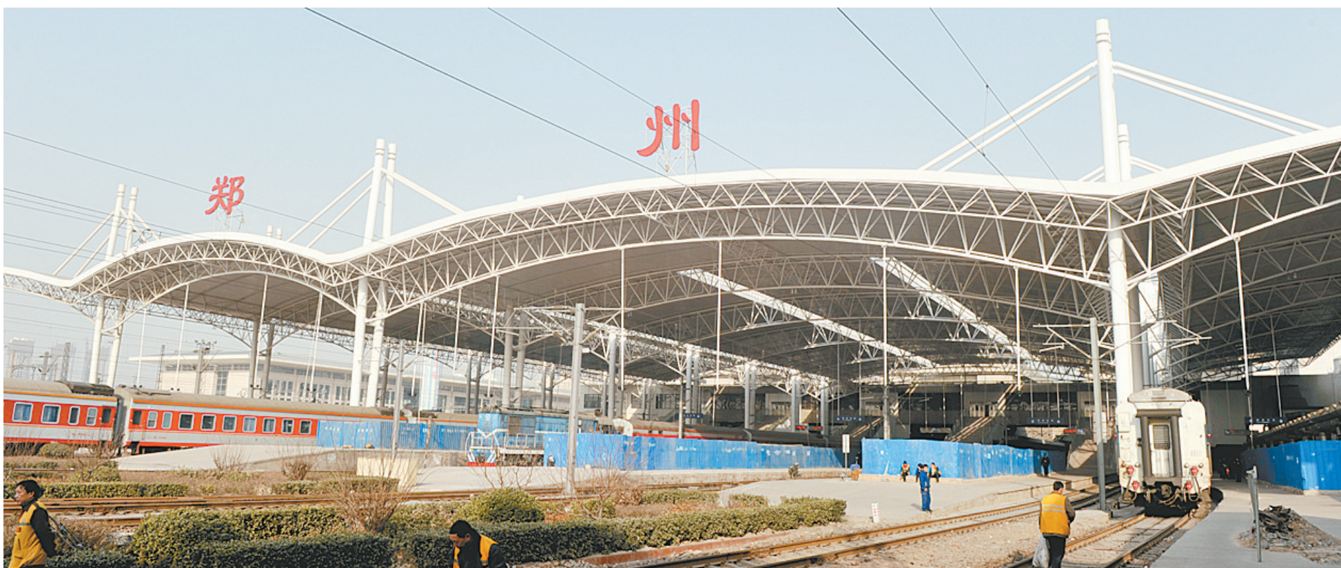
郑州火车站新建的5万多平方米的无站台柱风雨棚竣工投入使用,东西最大跨度145.55米,从此旅客告别露天候车。
