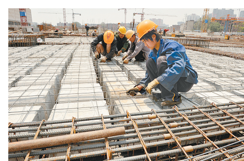
2009年5月 工人正在广场施工。
