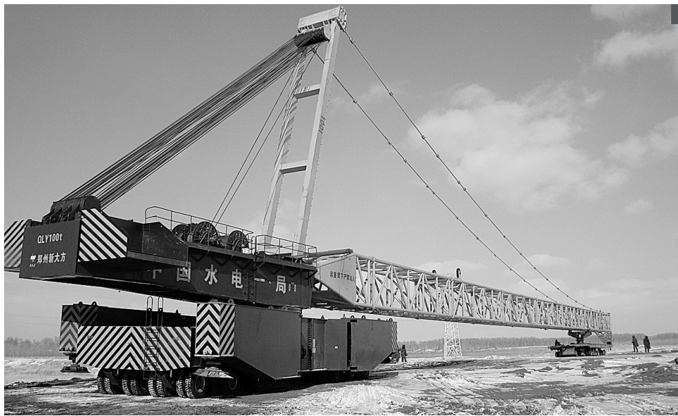
在吉林长岭腰子风电场上,施工人员正在操作“巨无霸”风电吊机进行转场作业。正是这台由郑州新大方重工科技机械有限公司自主研发的国内首台风电安装专用吊机,在这里创造了“中国制造”的新速度:一般的履带吊造价昂贵,进场需修筑专用道路,从一个机位到另一个机位转场需4小时左右,而这个自身重约300吨的郑州造“巨无霸”轮胎吊风电吊机仅需1个小时,且可经受零下35℃低温天气和10级强风的考验。
