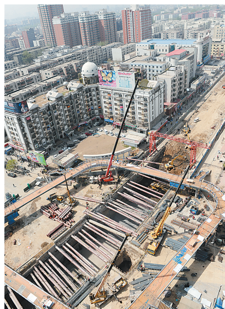
建设中的东风路——文化路下穿隧道工程
