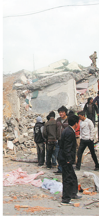
玉树地震灾区房屋倒塌严重，多数成为一片废墟。
