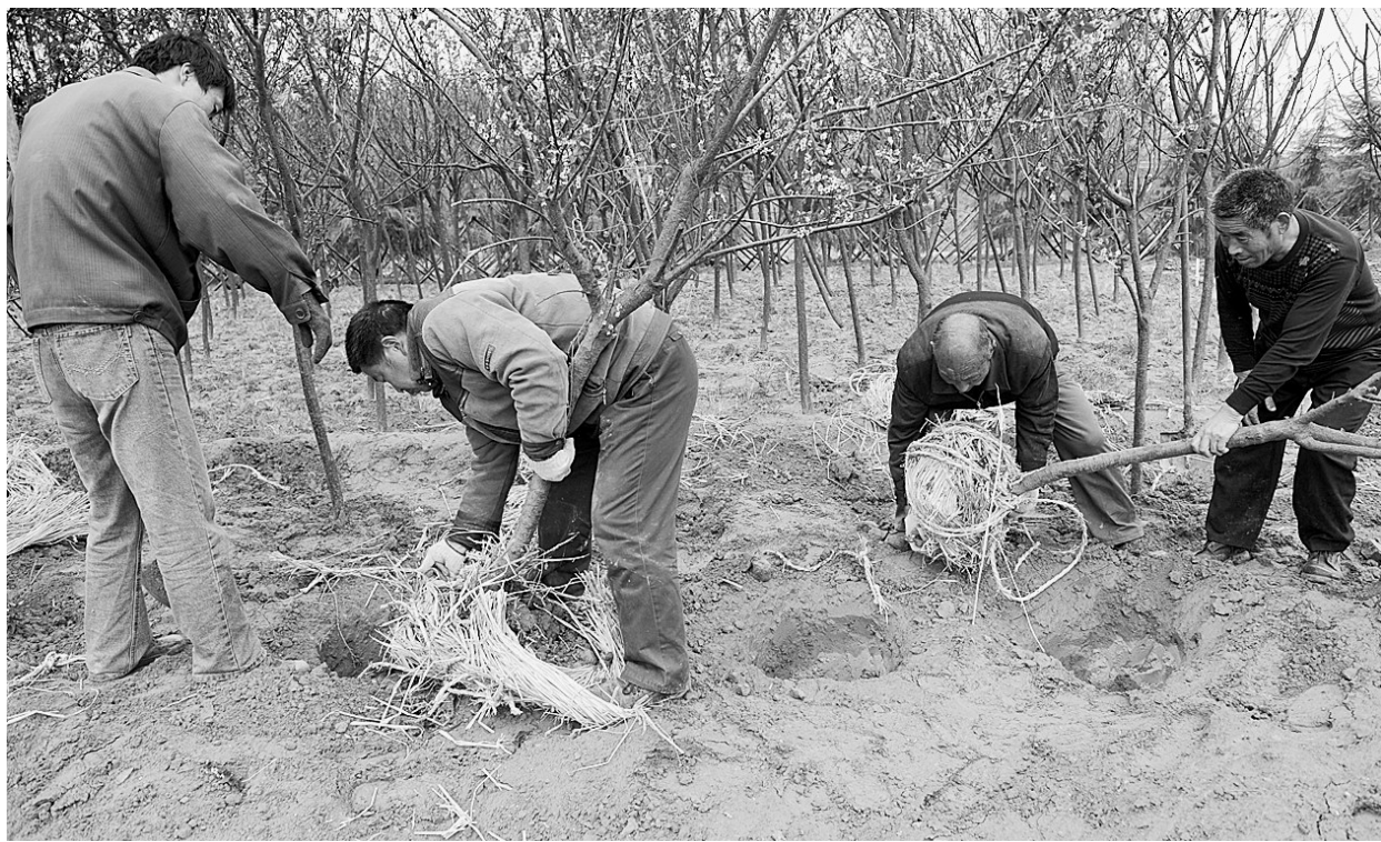
昨日,江连绿地公园施工人员正在紧张地栽种地被植物。据介绍,该项目是我市创建绿化模范城市重点工程之一,位于江山路连霍高速下道口,该项目占地186.4亩,目前60%的土方已挖填好,栽种雪松、大叶女贞等20多种树木,建成后将大大改善北入市口的绿化景观质量。
