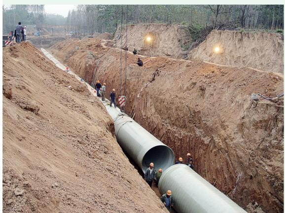
生态水系输水工程通过管道为河道提供水源,埋设输水管道全长38.6公里。
