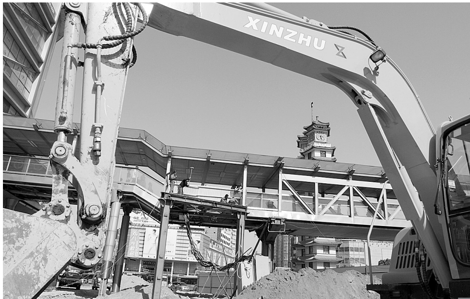
为给郑州地铁二七广场站让路,备受省人民关注的二七广场西侧正兴街段人行天桥开始拆迁。据悉,由于交通整改难度较大,施工方表示将采取分期、分段的方式拆除天桥,计划在2011年12月地铁站建成后,将按照原貌恢复重建正兴街段天桥。 本报记者 李焱 摄
