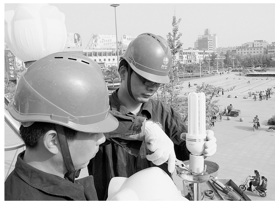
为倡导低碳照明,近日新郑市对市区主要街道62盏电杆806盏路灯更换,将250瓦普通照明灯全部更换为13瓦节能灯。 本报记者 李伟彬 通讯员 王帅 摄
