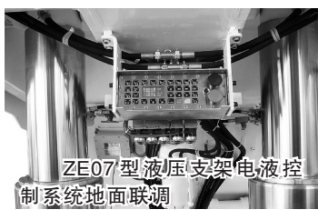
ZE07型液压支架电液控制系统地面联调
