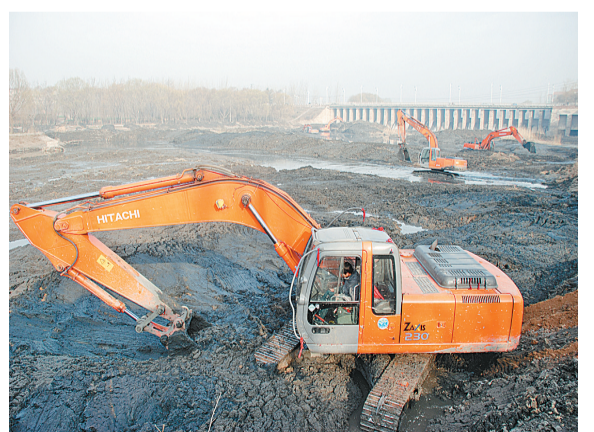
河道清淤治理
