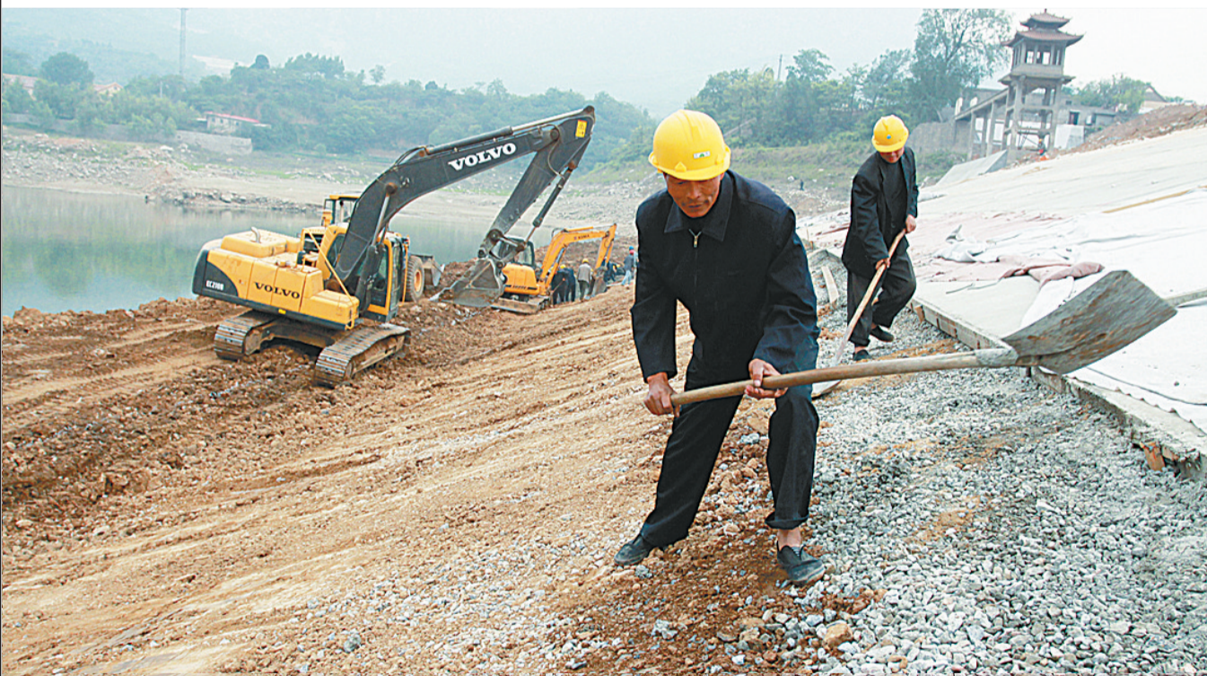
水库除险加固
