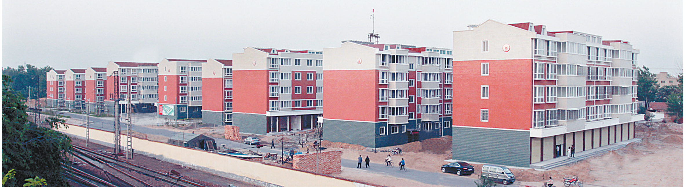
建设中的新郑市薛店镇大吴庄村新型农村社区
