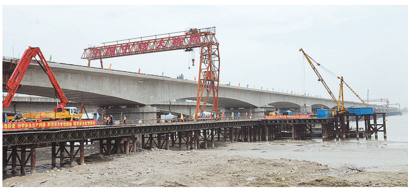
这是建设中的钱江铁路新桥。新华社发
