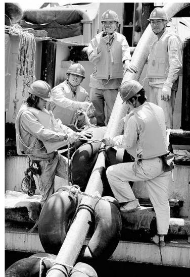
5月26日,厦门电力第一进岛通道扩建工程开始在厦门海域敷设海底电缆。该工程西起集美,东至厦门岛。电缆截面2500平方毫米,是目前国内最大截面海底电缆,输电容量达600万千瓦,长度3.75公里,重达360吨。3根同样规格的电缆将先后跨越厦门东部海域,工程预计在7月5日完成。国家电网福建省第二电力建设公司在敷设海底电缆。
