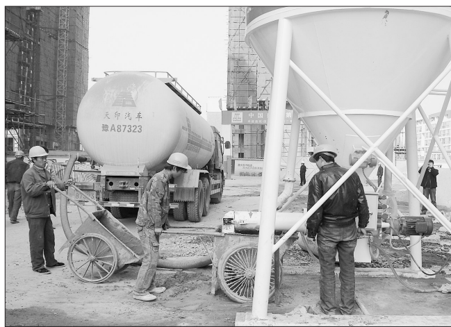
散装预拌砂浆在我市建设工程中得到应用
