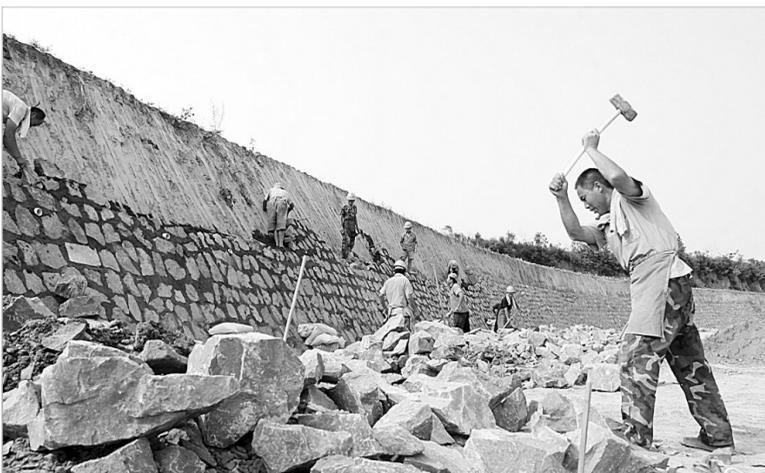
随着汛期临近，新郑市积极对辖区内水库进行加固，同时加快溢洪道工程施工速度。昨日，记者在该市唐寨水库看到，施工人员正加紧对水库溢洪道进行除险加固。 本报记者 高凯 摄
