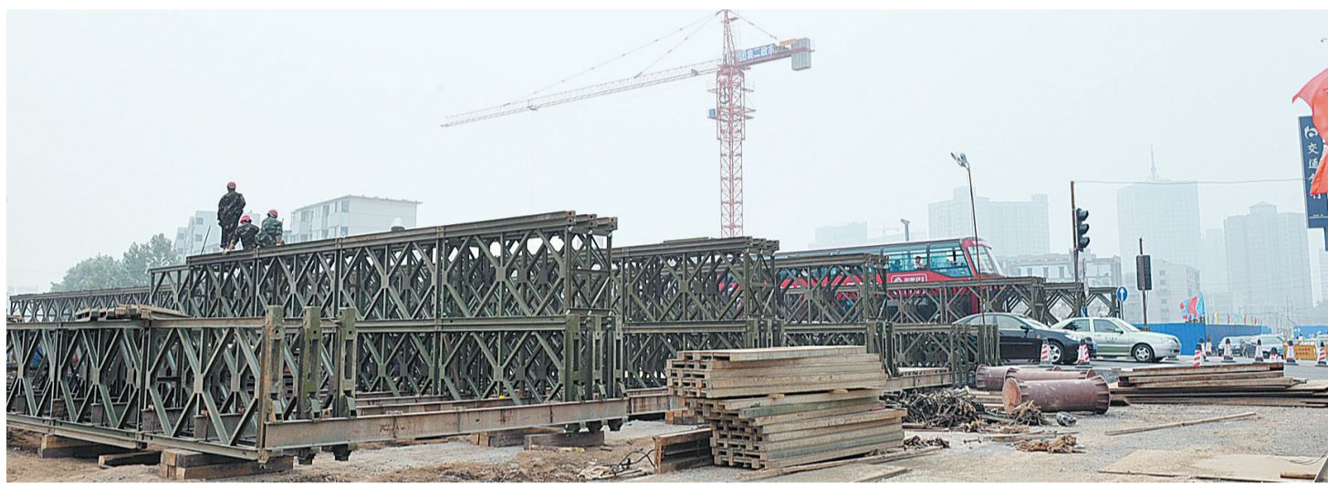
京沙快速路施工现场,施工方在中原路南侧搭建钢架桥,方便车辆通行,北侧钢架桥已通车。本报记者 丁友明 摄
