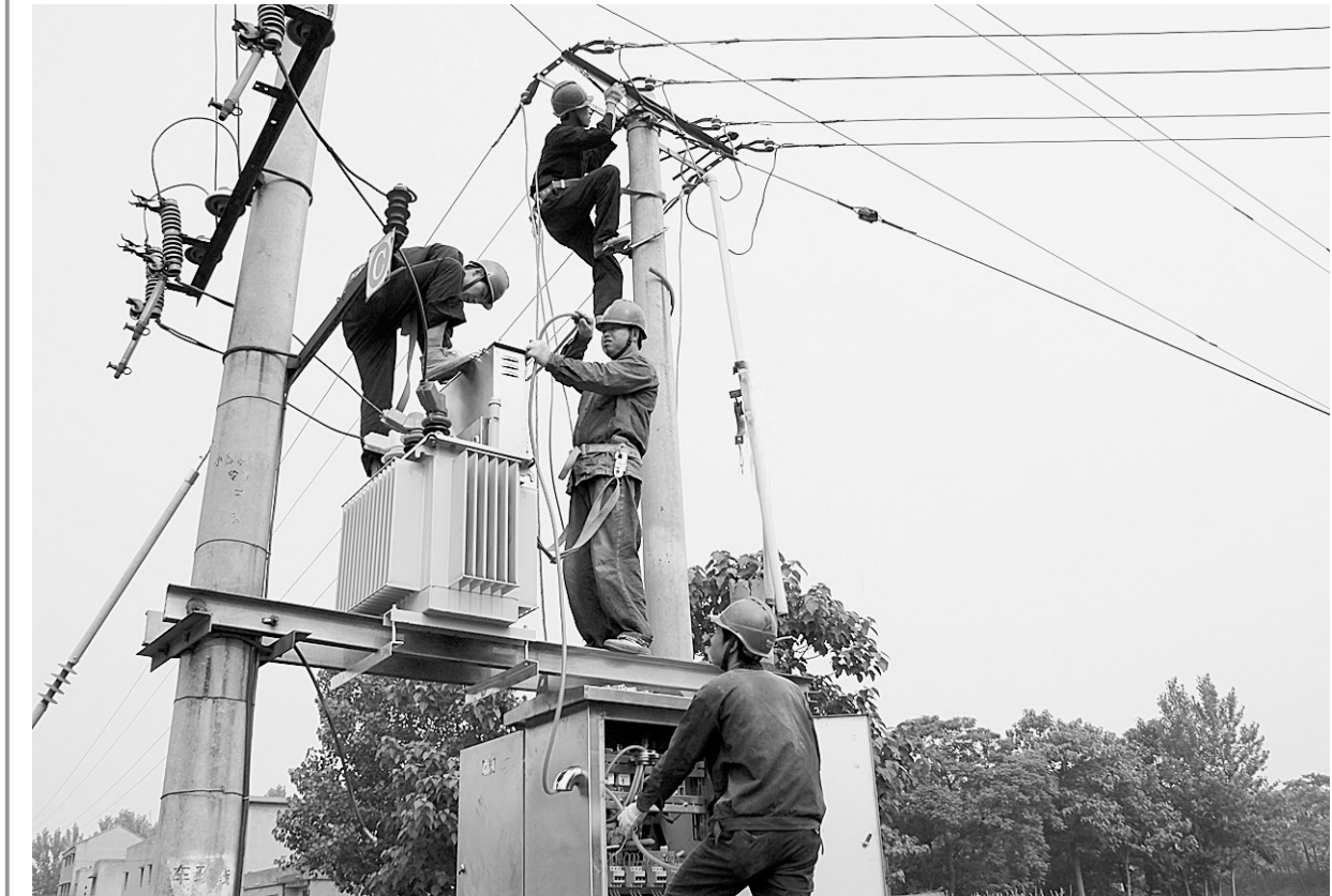
为确保农村电网安全,近日,新郑市对全市150台农用变压器增容改造。图为该市电力服务公司技术人员对和庄镇小吴庄村50千伏变压器进行增容改造。
