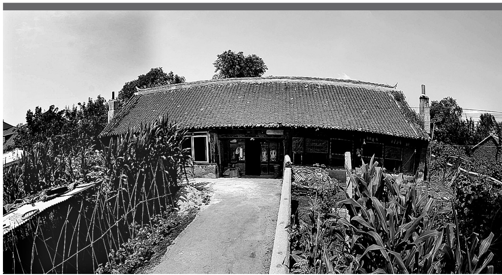
近日,辽宁省鞍山市文物部门进行文物普查时,在千山区宁远镇张忠堡村普查到一幢建筑精美的老宅子。后经鞍山市文物普查队实地鉴定,这是一幢保存非常完整、至少有200多年历史的清代民宅。它是一座典型的硬山式建筑,青砖黑瓦的老宅基本保持着原来面貌。80岁的刘富林仍住在老宅里。
