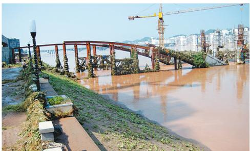
这是7月20日拍摄的被洪水冲毁的国道318线渠江二桥的钢架桥梁。
