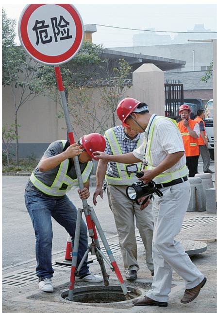
昨日,二七区市政所工作人员自主研发了井盖警示标示,利用螺栓张力原理,使新的标示牌能够牢固地卡在井圈上,改变了原有标示牌固定不稳的缺陷,避免因雨水冲刷、缺失井盖而造成的安全隐患。 本报记者 陈靖 摄
