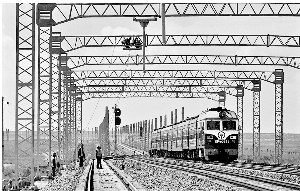
青藏线西宁至格尔木增建二线铁路电气化工程进展迅速,今年年底可望全线建成。连接青海和西藏两省区的西格二线电气化铁路通车后,将为中外游客到青海湖观光旅游增添一条快捷、环保的绿色通道。青藏铁路西格段增建二线工程东起青海省西宁市,向西途经青海湖北岸,横穿柴达木盆地,跨越著名的万丈盐桥后到达格尔木市。图为施工人员在西格二线青海湖车站进行电气化铁路施工。新华社发
