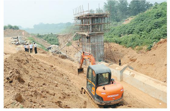
昨日,记者在荥阳市 河王水库除险加固工地施 工现场看到,新建的水库 启闭塔和地下管道主体已 基本完工。据了解,荥阳 市是郑州地区水库除险加 固工程最多的县级市,今 年国家、省、市共投资 8722万元对7座中小型 水库进行加固坝体、清淤 增容、修建溢洪渠、增设闸 坝等。截至目前,已完成 工程总进度90%。主体 工程预计8月底全部完 工。工程完工后,总库容 可达7864万立方米,可以 达到抵御500年一遇的洪 水标准。
