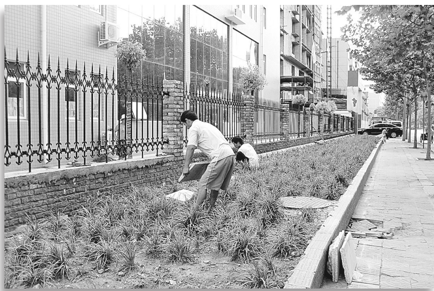
近日,经八路办事处广泛动员辖区单位,积极开展沿街楼体立面专项整治工作。目前,辖区沿街围墙已基本粉刷完毕,路边花坛整治工作正在进行。 本报记者 唐强 摄
