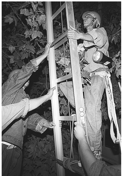
14日21时,西区域城中村冉屯的一条380伏电线短路,造成附近区域停电,市供电公司抢修人员火速赶赴现场展开抢修,该区域供电很快恢复。本报记者 丁友明 摄
