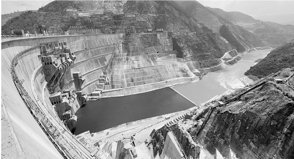
8月25日,位于云南省南涧县与凤庆县交界的澜沧江中游河段上的小湾水电站单机容量70万千瓦的4号机组正式投产发电,标志着我国水电装机容量突破2亿千瓦大关,稳居世界第一。小湾电站是国家重点工程和西部大开发“西电东送”标志性战略工程,共6台机组总装机容量420万千瓦机组已全部投产。
