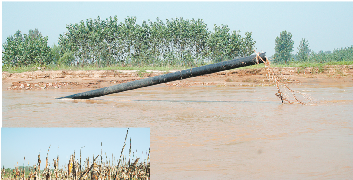
上图 在洛阳偃师伊河特大桥上游1公里处的水下煤气管道断裂,管道一端已经翘出水面。 左图 事故现场,岸边的一小块玉米地庄稼被烧毁。 新华社记者 汪平 摄
